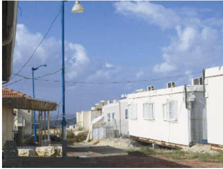
מתחם גני ילדים ובית ספר "ברסלב" ברח' ר' עקיבא המוזנים בחשמל מתאורת מאור רחוב
