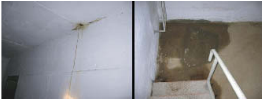
רטיבות במקלט ברח' השומר פינת סיני (ינואר 2011)
