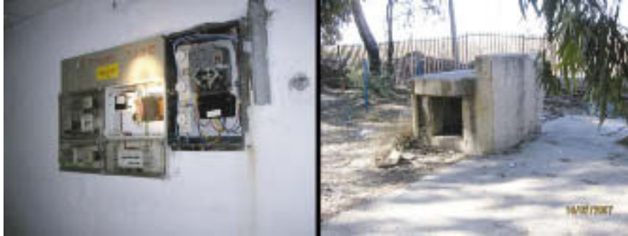
מערכת חשמל חשופה במקלט ברח' החלוצים 5 (ספטמבר 2010)
