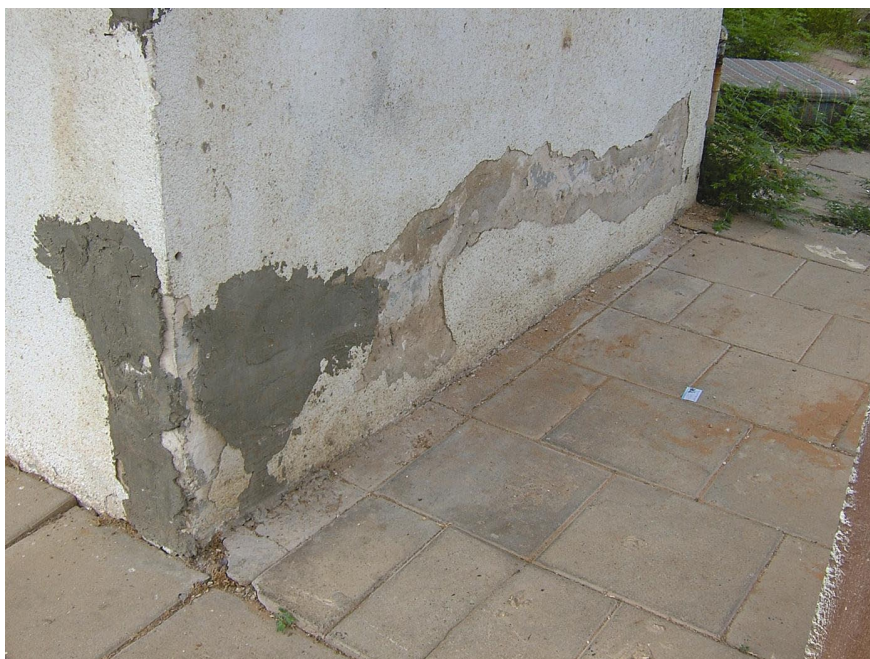
דליפות מתמשכות של מי ביוב המחלחלים לכיוון היסודות הגורמים לקילופים קשים בתחתית הקירות
