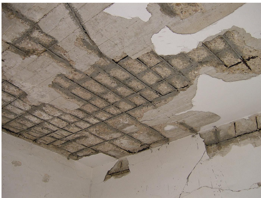
תקרת חדר נמצאת במצב התפוררות עקב רטיבות במשך שנים, עד כדי יצירת מפגעים בטיחותיים המסכנים את דיירי הדירה
