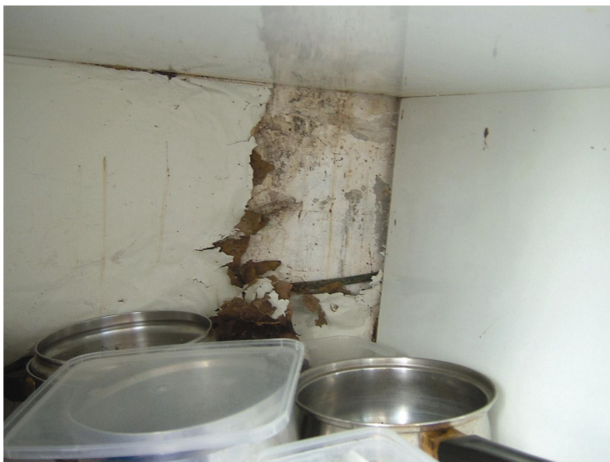
נזקים קשים וריקבון בגב ארון המטבח עקב דליפות מסיביות של מים מהכיור
