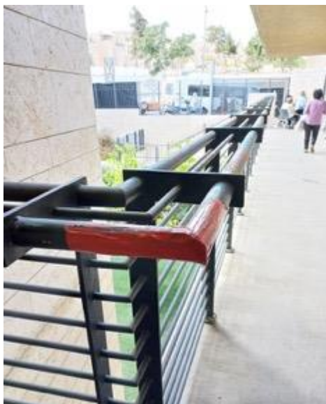
פינת מאחז יד חדה בסמוך לדלת הכניסה, וחלקי פרוזל חדים לאורך מאחזי היד במעון לקשיש בגילה.
