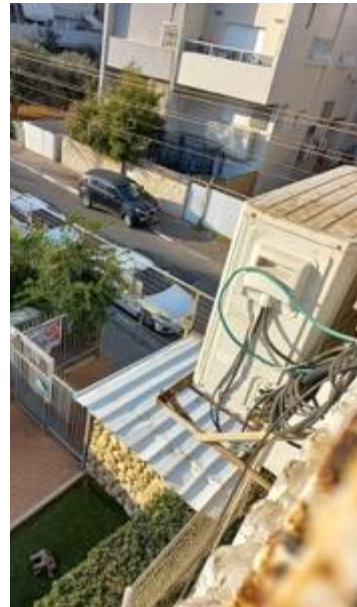
תושבת מעבה מזגן חלודה מעל חצר פעוטון במרכז קהילתי ברח' שאול המלך. נדרש לבדוק את יציבותה.
